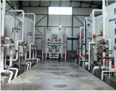
ZORLU ENERJİ-L.BURGAZ DEMİNERALİZE SU ÜRETİM TESİSİ
